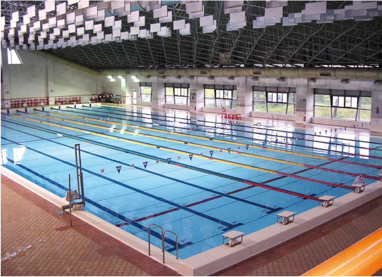
安裝實例：新竹縣立游泳館
