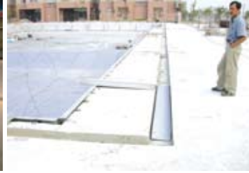
不鏽鋼游泳池施工
