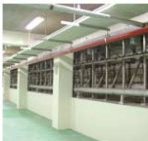
池體完成外側
