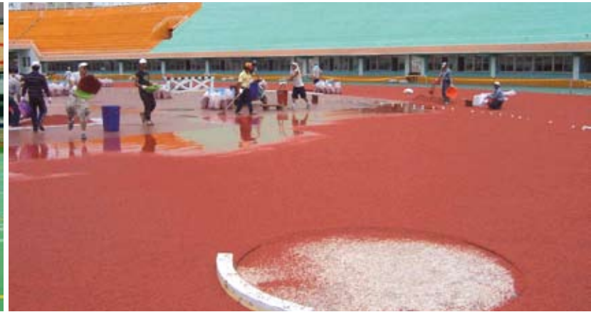
鍊球區PU施工
