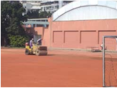
紅土球場施工
