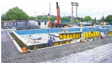
搬運FRP單元
